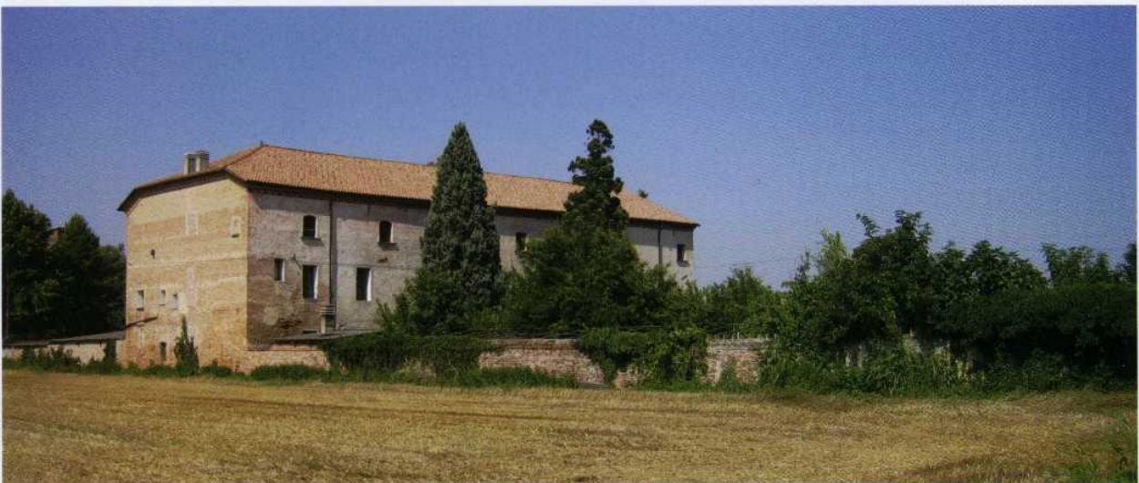
Altare di Sambruson. Edificio monastico già di proprietà dei monaci di San Giorgio in Alga, acquistato nel secolo XVII dalle monache benedettine del monastero di Santa Giustina di Venezia ed attualmente utilizzato come casa di accoglienza, nella particella n. 12 del Catastico della Sesta presa. Dolo, Altare di Sambruson (ed. CONSORZIO DI BONIFICA BACCHIGLIONE BRENTA), e in due recenti immagini dell'esterno e del portico interno a piano terra.
